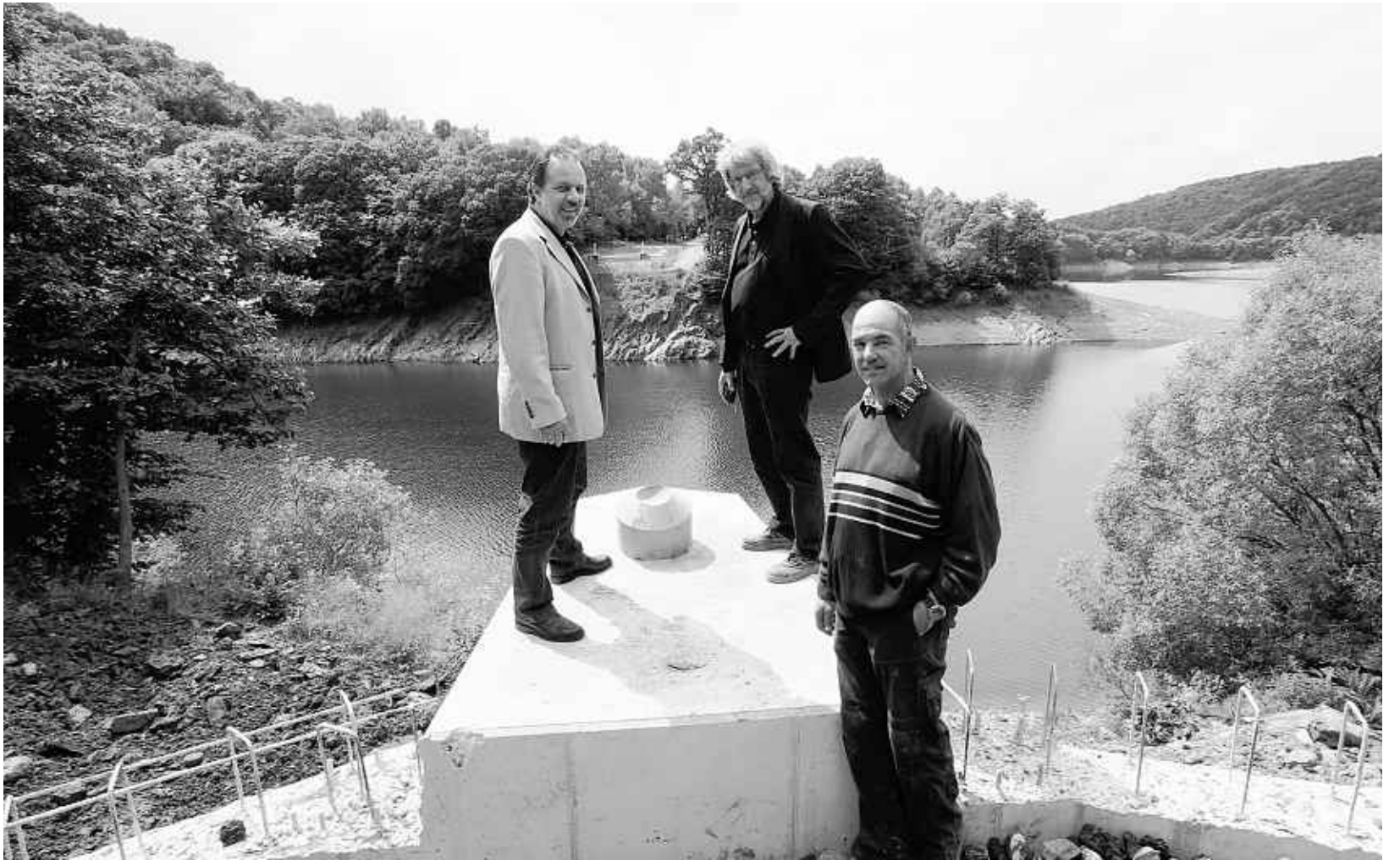
Die Fundamente sind fertig: In dieser Woche kann nun mit dem Aufbau der Urtseebrücke begonnen werden.
