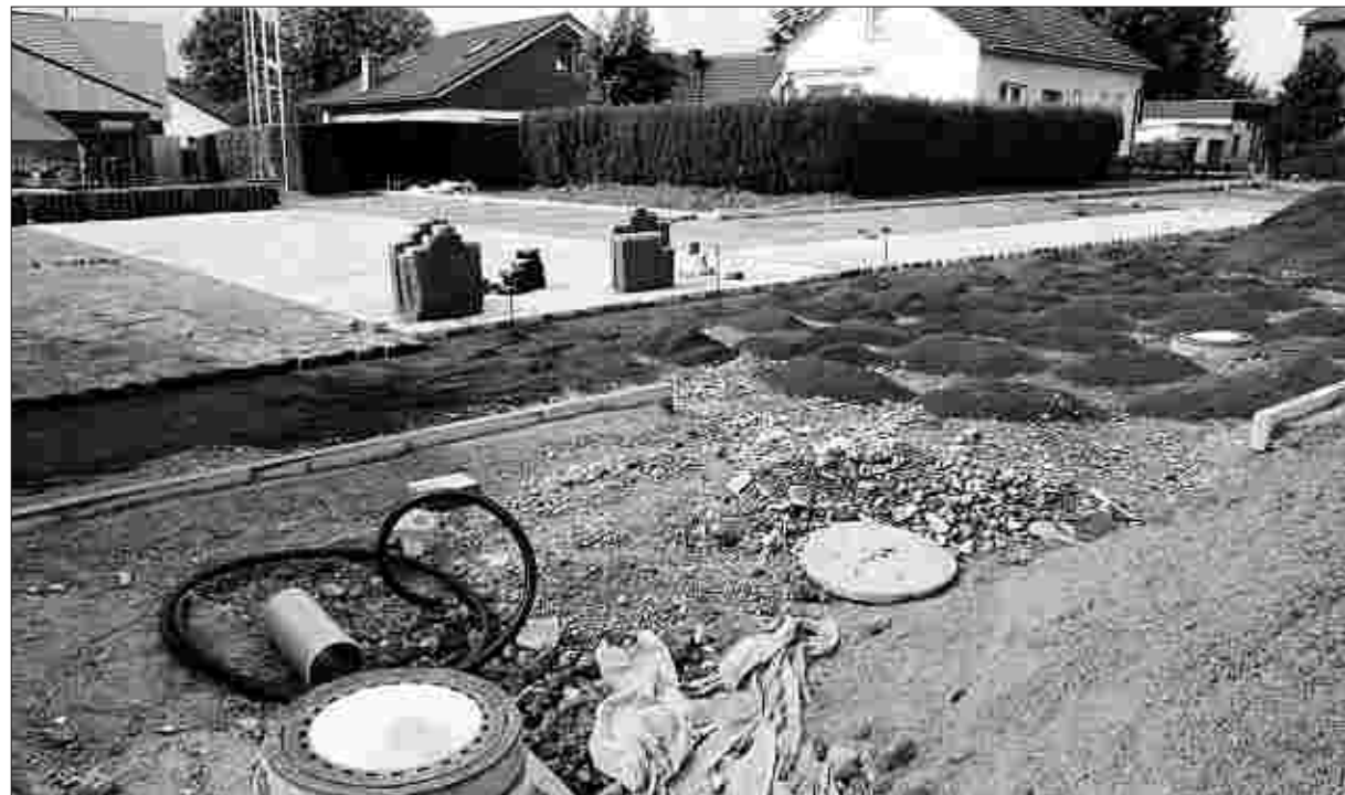
Das mit Lava aufgefüllte ehemalige Kellergeschoss soll das gesamte Niederschlagswasser des neuen Parkplatzes oberhalb vom Bürger-Casino in Imgenbroich auffangen und dann gedrosselt in den Mischwasserkanal der Trierer Straße abgeleitet werden. Foto: P. Stollenwerk
