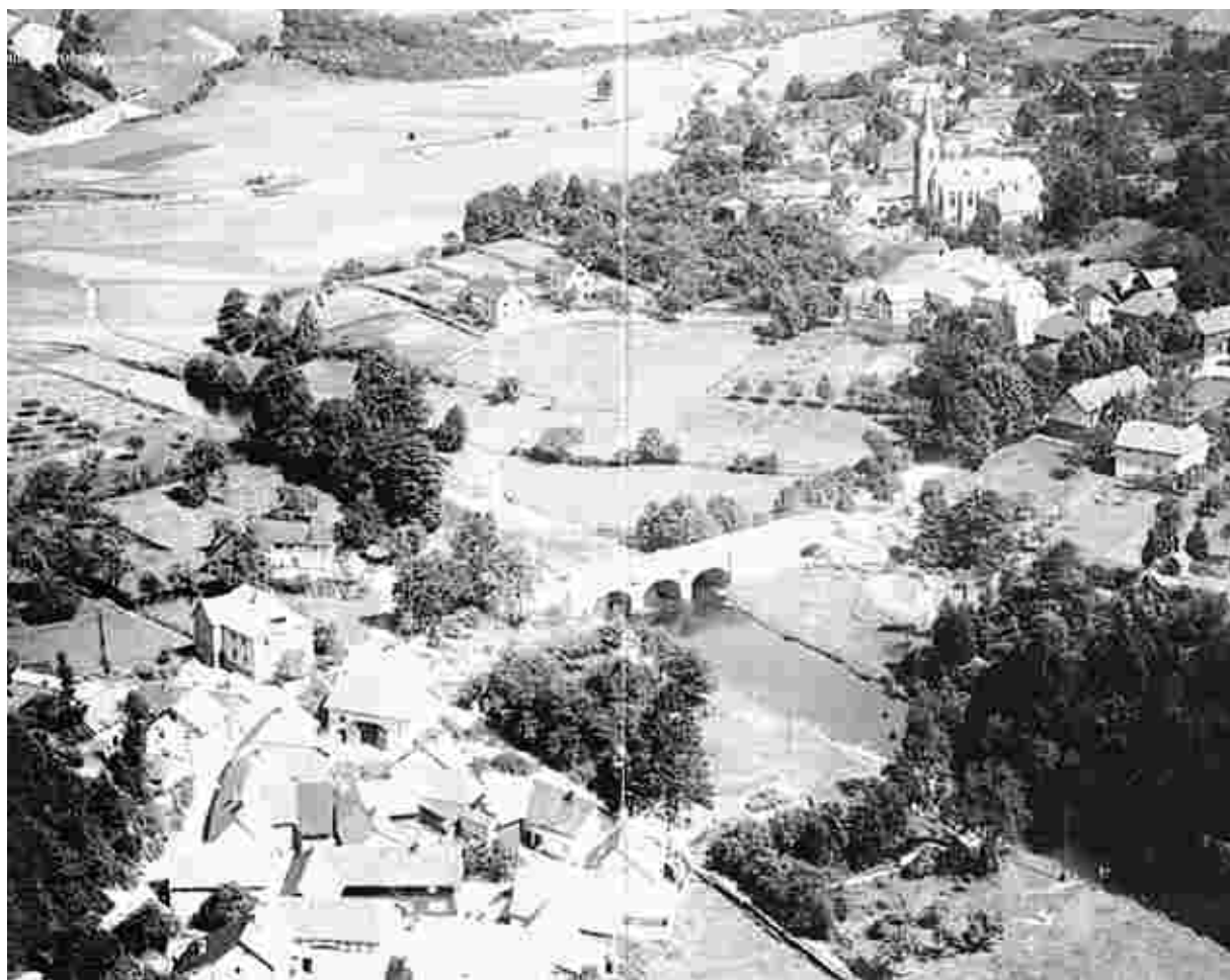
Ein Bild aus alten Zeiten: Pleushütte und Einruhr waren lediglich durch die Rur voneinander getrennt. Im Zuge der Aufstockung der Rurtalsperre versank Pleushütte im See. Einruhr stieg zu einem bedeutendem Ort für den Tourismus auf.
