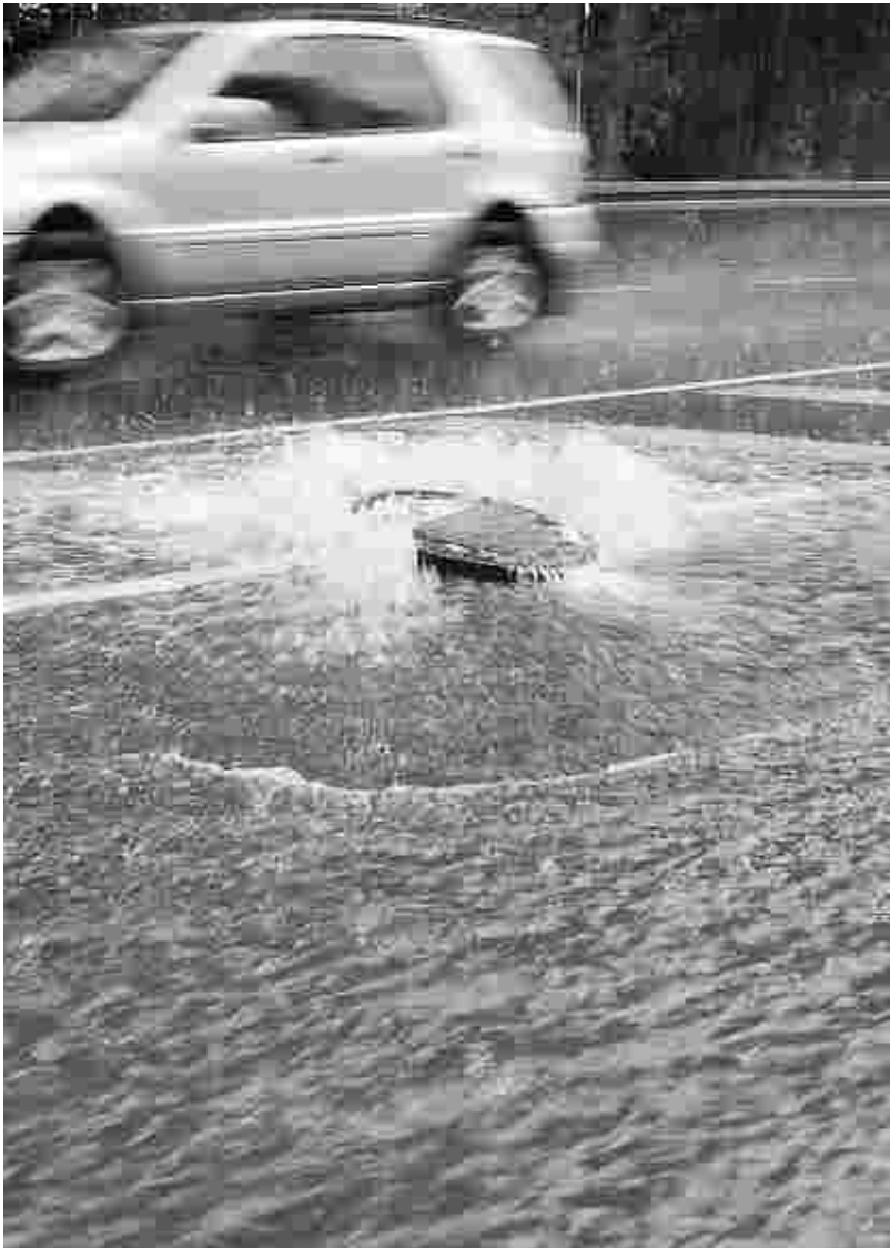
Die Gullys auf den Straßen konnten die herunterstürzenden Wassermassen nicht aufnehmen und wurden zum gefährlichen Hindernis.
