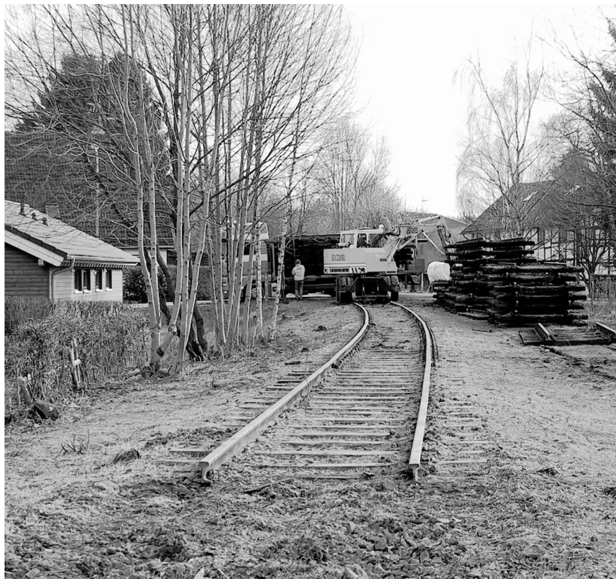
Bald sind Schienen und Schwellen von der alten Vennbahntrasse abgebaut (wie hier in Roetgen am Übergang an der B 258, Bereich Bahnhof). Dann beginnen die Bauarbeiten an dem Radweg Vennbahn-Route. Fotos R. Palm
