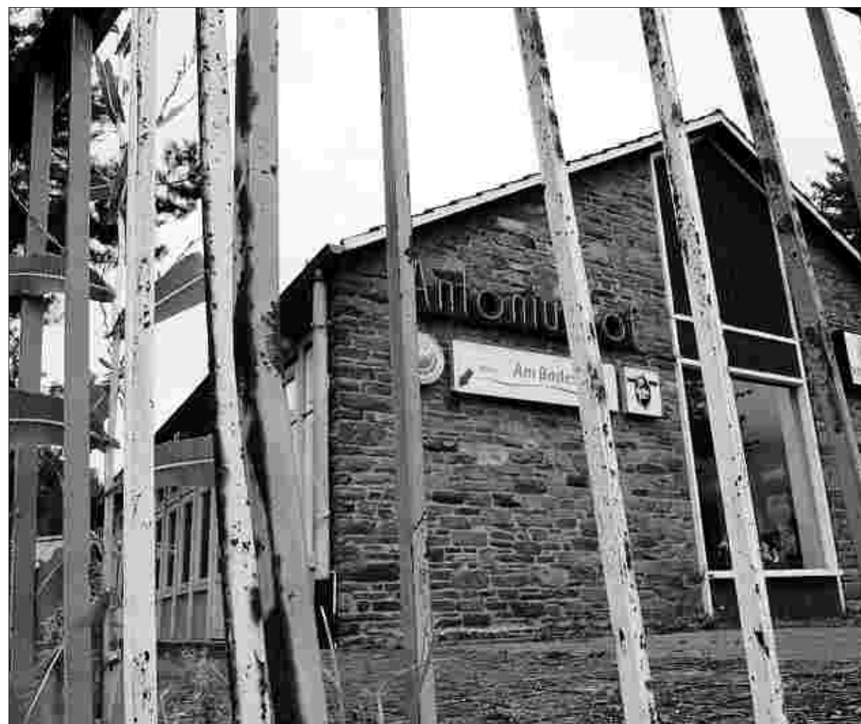
Der Antoniushof am Rurseezentrum bekommt ein neues Gesicht: Der Charme der 60er Jahre soll mit der großflächigen Sanierung verschwinden. Foto: P. Stollenwerk
