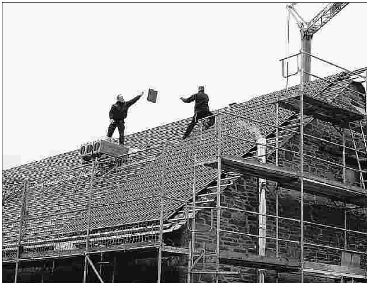
Rund um das künftige Nationalparktor sind die Handwerker im Einsatz: Gestern wurde das Dach der früheren Molkerei gedeckt. Foto: P. Stollenwerk
