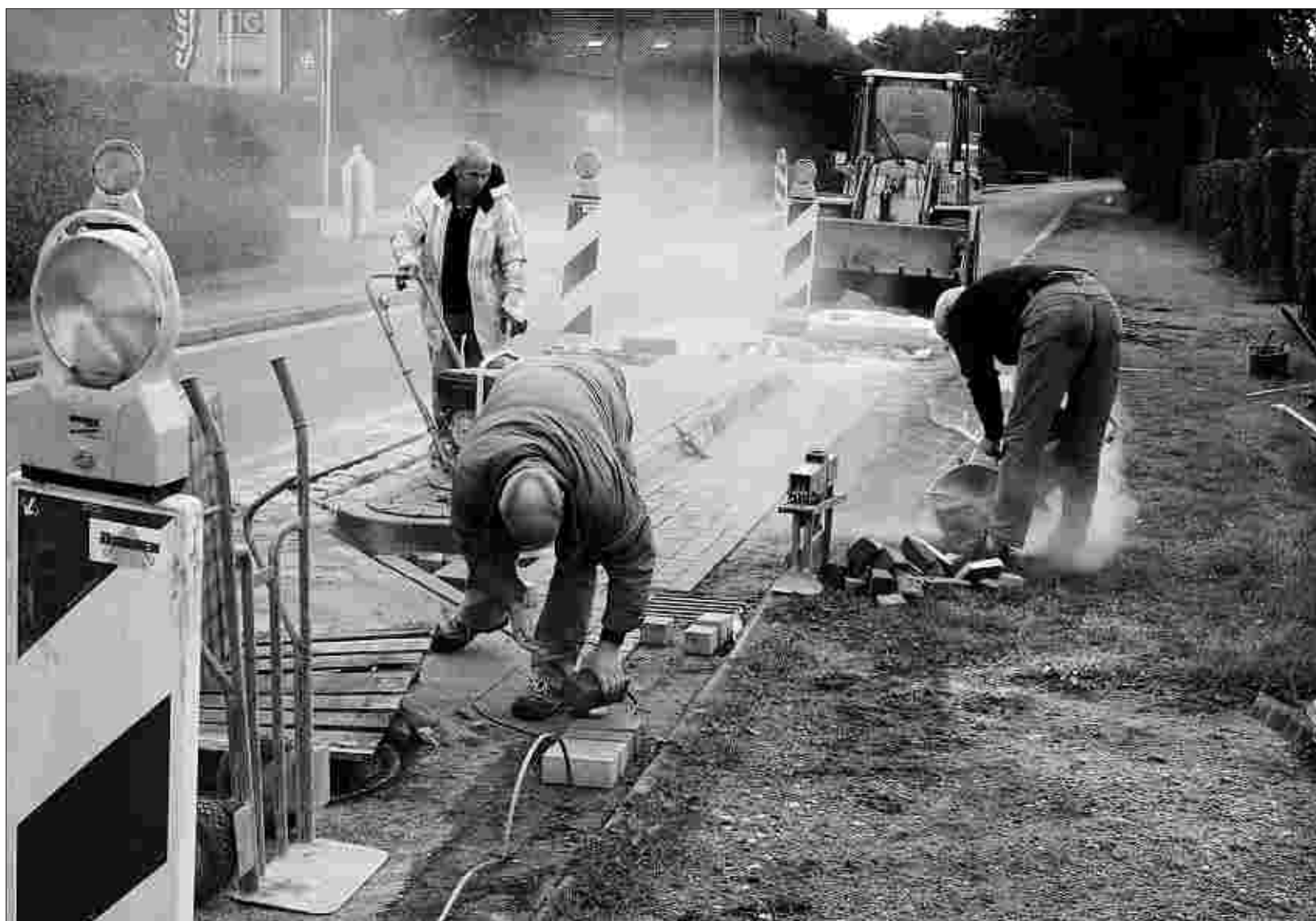
Der Bau von zahlreichen Inseln als dauerhafte Maßnahme zur Verkehrsberuhigung auf der Straße Hengstbrüchelchen in Imgenbroich wirbelt eine Menge Staub auf. Foto: P. Stollenwerk
