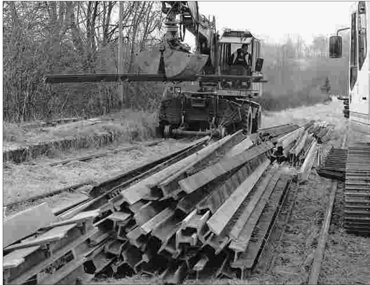
Das Ende der Eifeler Eisenbahn-Ära ist besiegelt: Zwischen dem Bahnhof Monschau (Bild) und Kalterherberg ist jetzt mit dem Abbau des Gleiskörpers der Vennbahn begonnen worden. Foto: P. Stollenwerk
