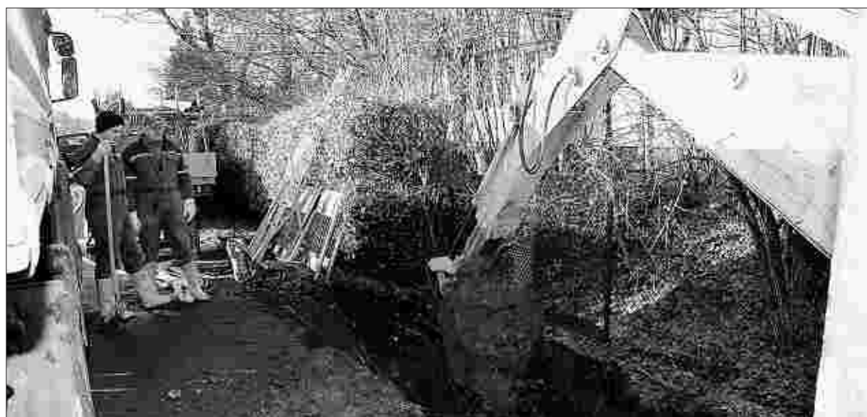
Die ganze Nacht und auch gestern tagsüber suchten die Perlenbach-Mitarbeiter mit Bagger und Schaufel nach der schadhafte Stelle an der Hauptstraße. Teile von Simmerath waren vorübergehend ohne Wasser.
