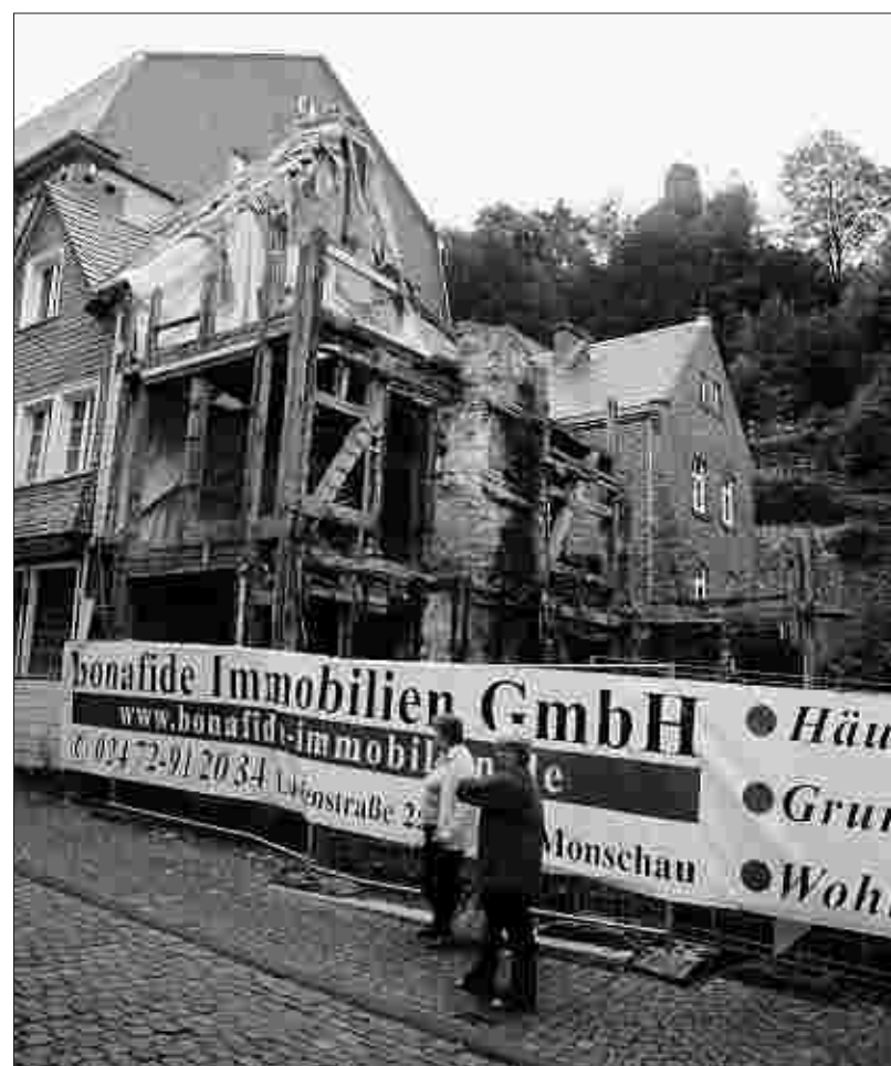
Ein Feuer zerstörte am 27. Dezember 2005 das Gebäude Laufenstraße 32, seither klafft eine Lücke im historischen Ensemble dieser Hauptfallstraße für den Stadtkern. Foto: Archiv/P. Stollenwerk
