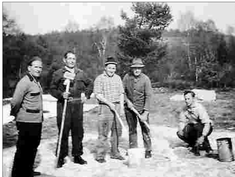
1953 richteten die britische Royal Air-Force den Bordwaffenschießplatz an der Brath in Höfen-Alzen ein. Das Foto zeigt deutsche Zivilangestellte bei Ausbesserungsarbeiten an den Zielscheiben.
